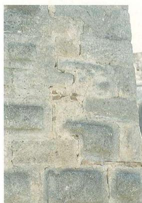
Détail de la "cointre" qui marque la reconstruction de la façade en 1862. Conformément aux devis, le maçon a réutilisé les pierres de la démolition mais, par endroits, il a été obligé de les retailler.
