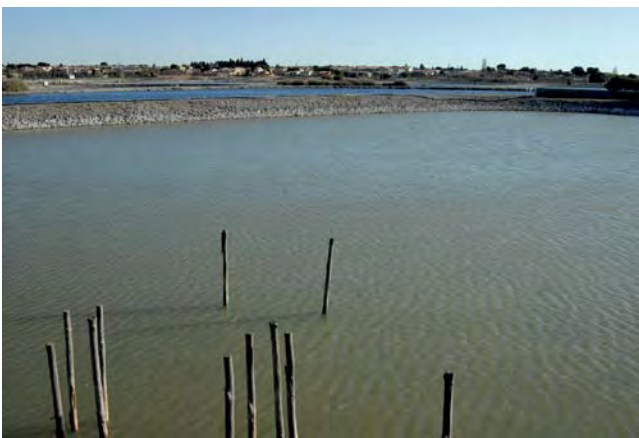
8 000 tonnes de matériaux sont nécessaires en moyenne pour la réalisation d'un bassin de lagunage. En photo, un bassin de Mèze.
