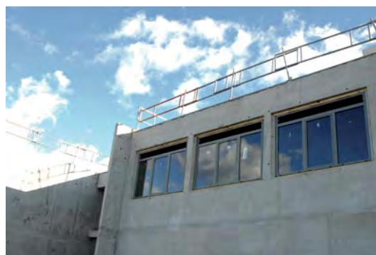
Le béton nécessaire à la construction du nouveau collège de Loupian a requis la fourniture de 10 000 tonnes de granulats béton.
