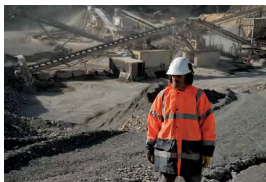
Au-delà des 11 salariés du site, 19 employés de sous-traitants sont nécessaires en permanence sur la carrière GSM de Poussan.
