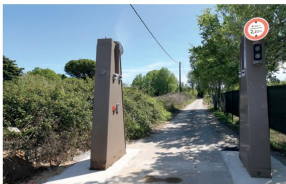
Des portiques fixes et automatiques ont été installés à la Moulière et sur les voies vertes de la commune pour contrôler les accès des véhicules à moteurs. Projet pris en charge à 100 % par Sète agglomération.
